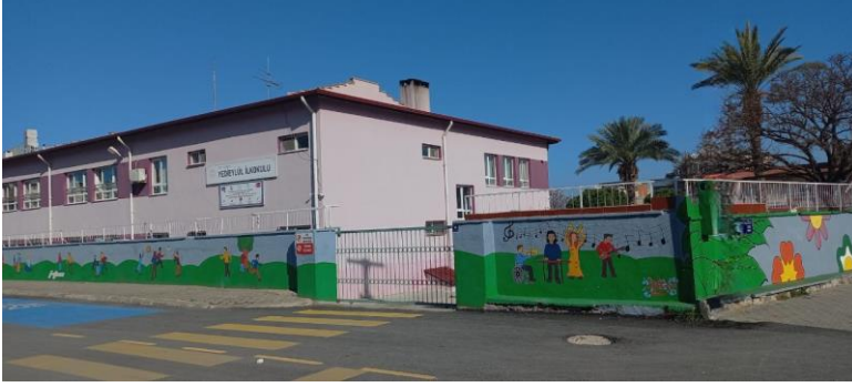
Resim 1: Yeni Bina Bahçe Girişinden Görünüm
